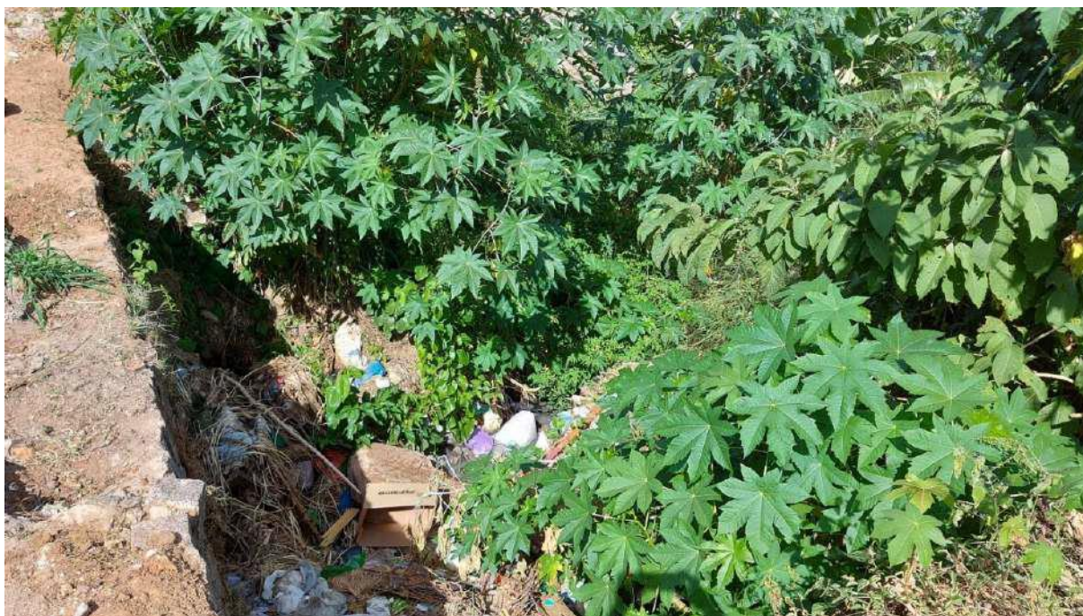
Figura 24 – Vala de Drenagem de Esgotos Fonte: Instituto Gesois, 2020.
