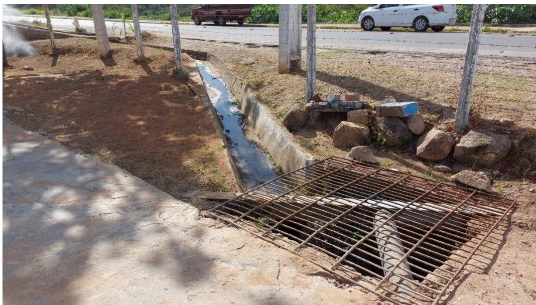
Figura 31 – Dispositivo de Drenagem
