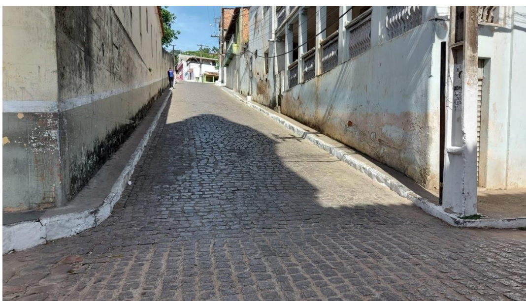
Figura 34 – Pavimentação de Vias Fonte: Instituto Gesois, 2020.
