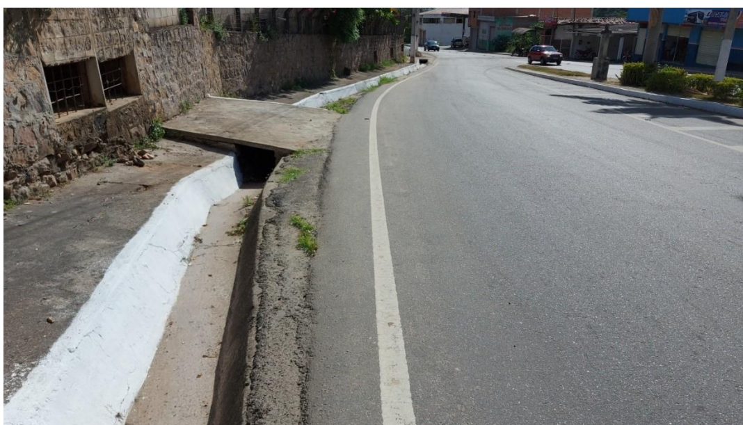
Figura 32 – Canaleta de Drenagem
